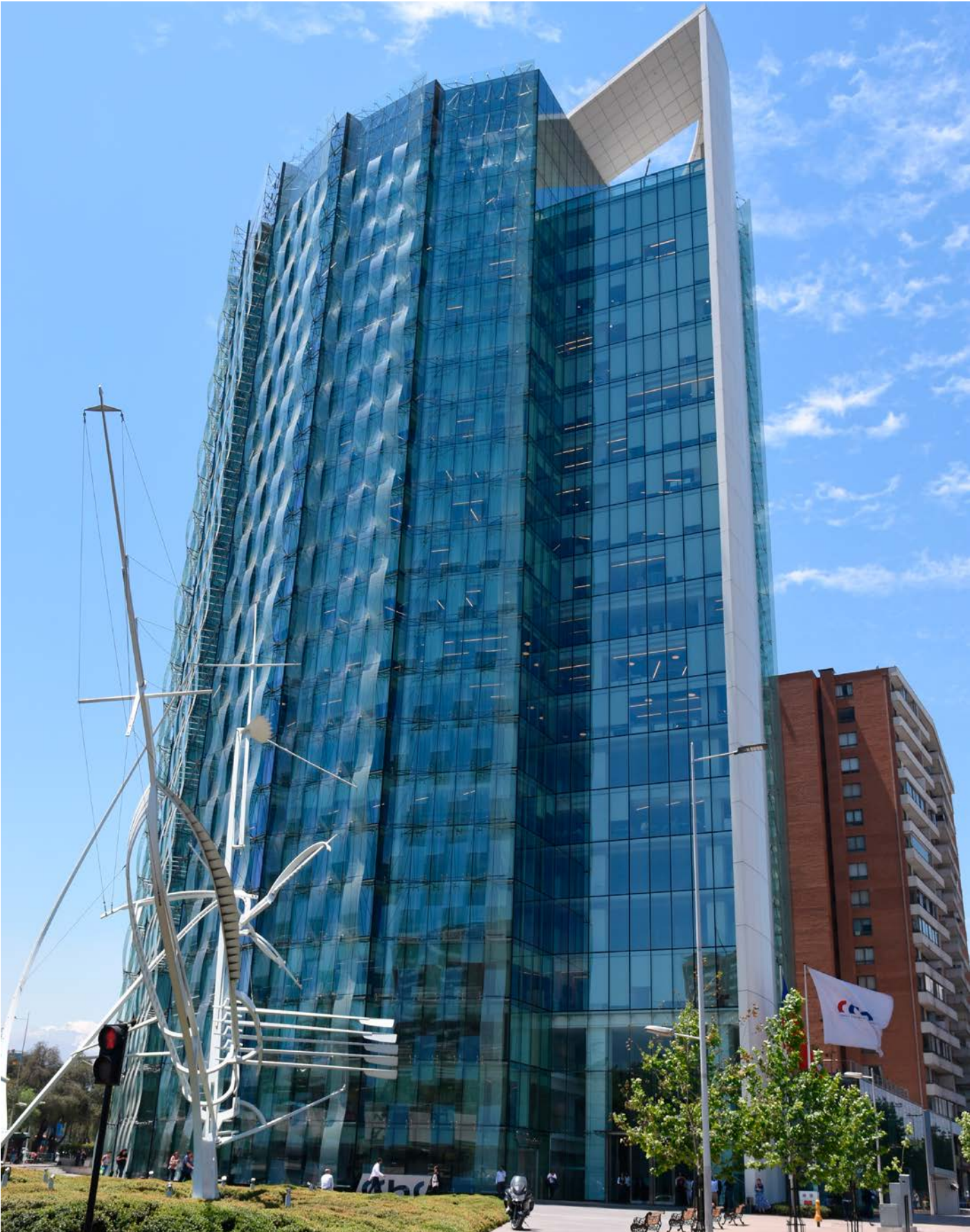
Edificio Corporativo CChC, ILC, Confuturo, Banco Internacional y Vida Cámara.
